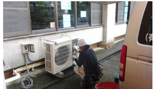
1階ロビー冷房装置設置工事
